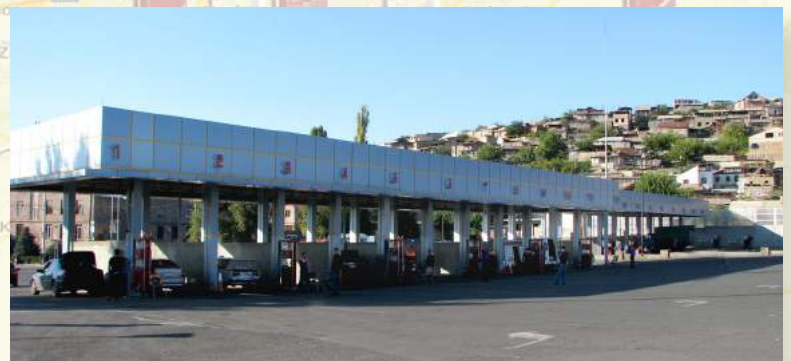
Мощная АГНКС, с более 20 заправочными постами
